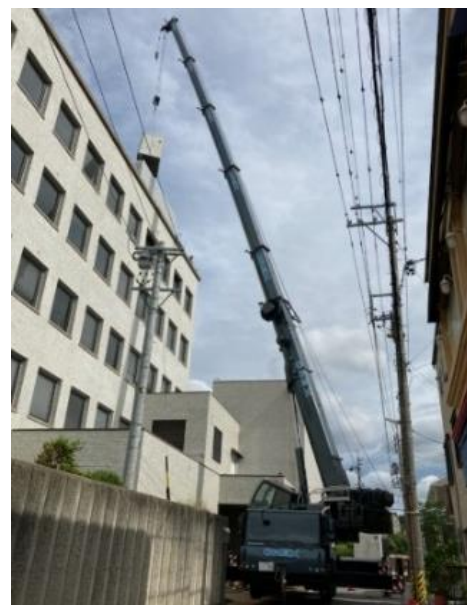
空調設備工事（10/28 @本所）
