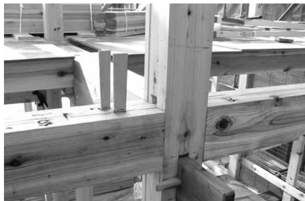
伝統構法(車知栓継ぎ)
