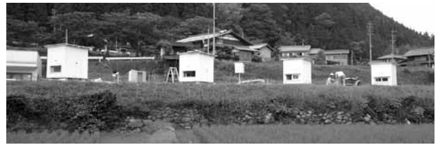
実験棟の全景(左から伝統A・現代A・伝統B・現代B)
