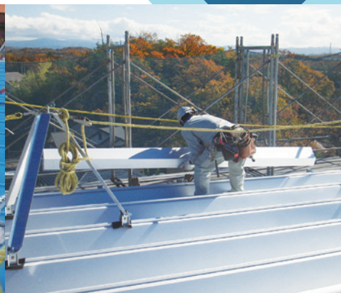
足場と折板上の相番作業(軒樋、水切取付等)従来は外部足場の親網へ安全帯を掛けていましたが、折板側の親網へ安全帯を掛けることにより、リスク低減
