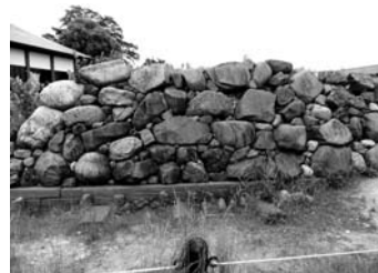
発掘された清洲城の石垣(清須市)
