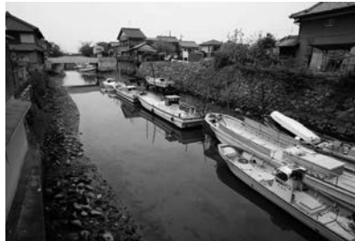
本多忠勝による「慶長の町割り」で掘削された水路(三重県桑名市)
